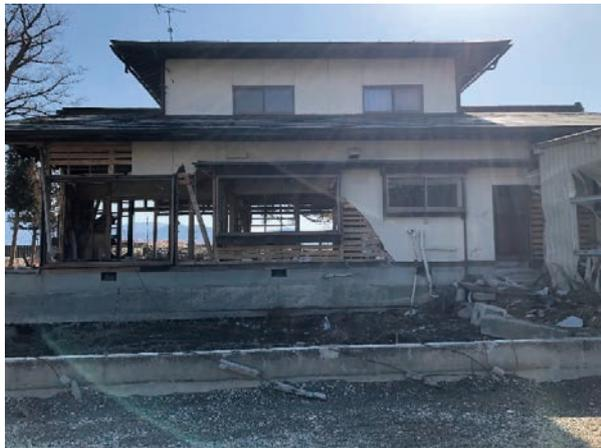
写真1 壁が倒壊した家屋
