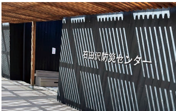
石田沢防災センター
