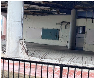
骨組みがむき出しになった小学校
